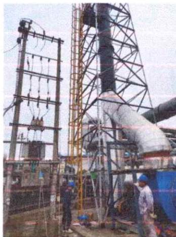
RTO 排气筒出口 05#
